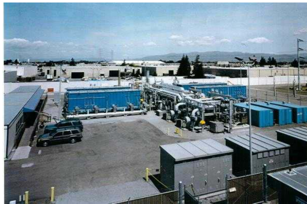
1.8 MW MCFC plant - S. Clara (CA, US)
